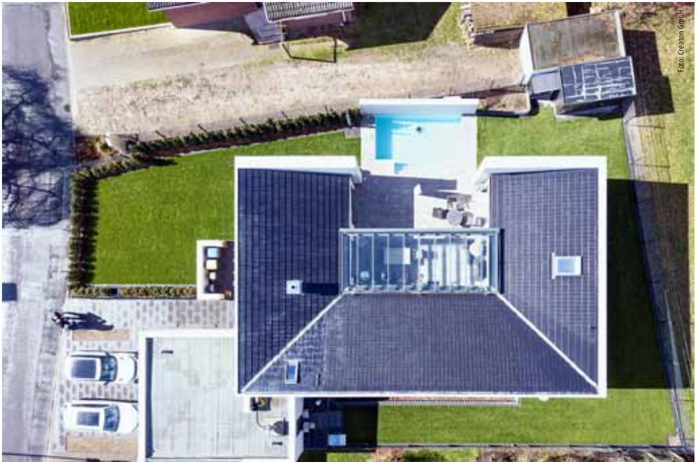
Aus der Vogelperspektive offenbart sich die Struktur des Hauses – dreiseitig durch Mauern umrahmt. Im Inneren entstehen dadurch drei Teilflächen, die durch unterlegte Metallkehlen verbunden sind.
