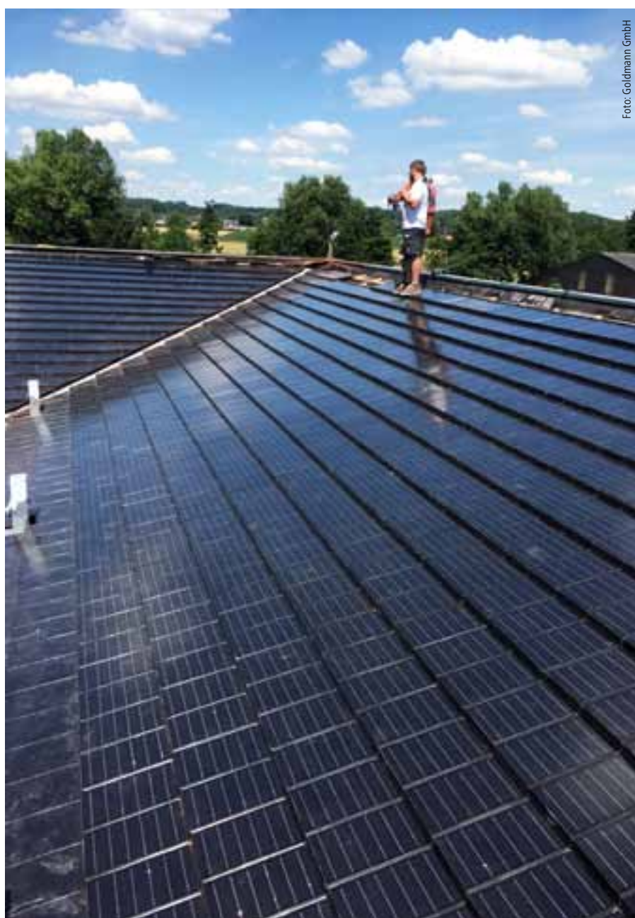
Fertige Teilfläche: Nur im Bereich der Firste, Kehlen und Traufen kamen normale Dachziegel zum Einsatz. So weit wie möglich wurden alle anderen Bereiche mit Solarziegeln bestückt.
