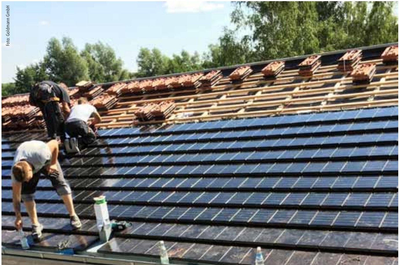
Das Goldmann-Team bei der Arbeit: Die Verlegung erfolgte nach einem Stringplan.
