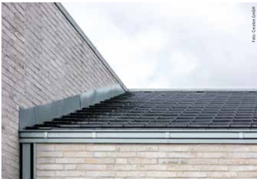
Unterlegte Metallkehlen statt Ortgang: Durch die hochgezogenen Mauern führten die Dachdecker einen metallischen Wandanschluss aus statt der üblichen Ortabschlüsse. Die obere Linie bildet eine Einheit mit dem First.
